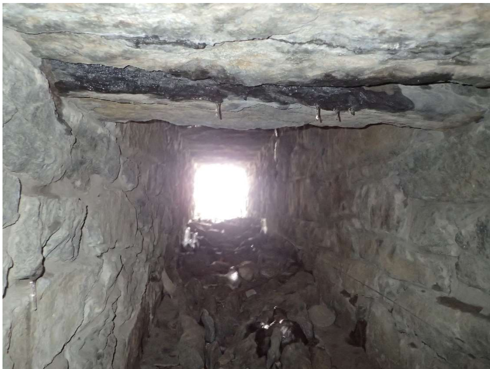
Foto 3: Průsaky vod skrz kamenné zdivo
