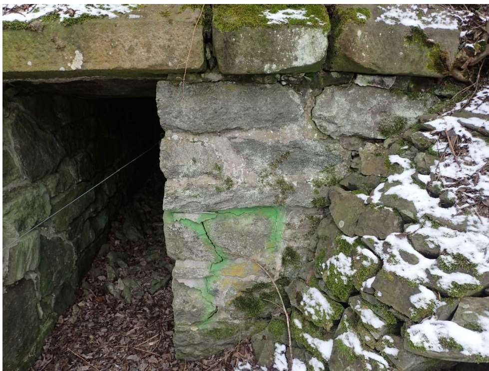
Foto 5: Rozrušené čelní zídky, vypadané spárování křídel
