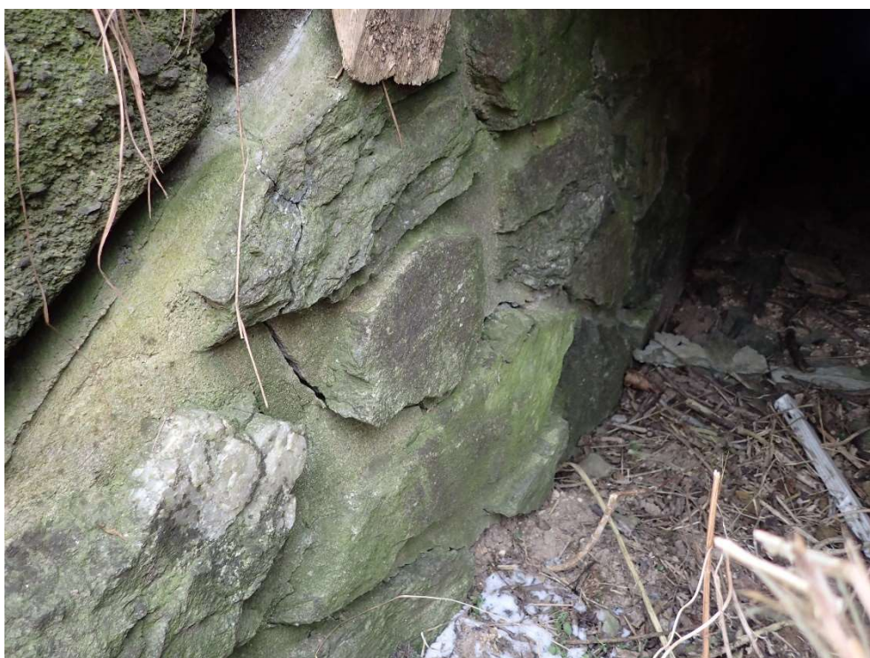
Foto 4: Místy uvolněné kameny a vypadané spárování
